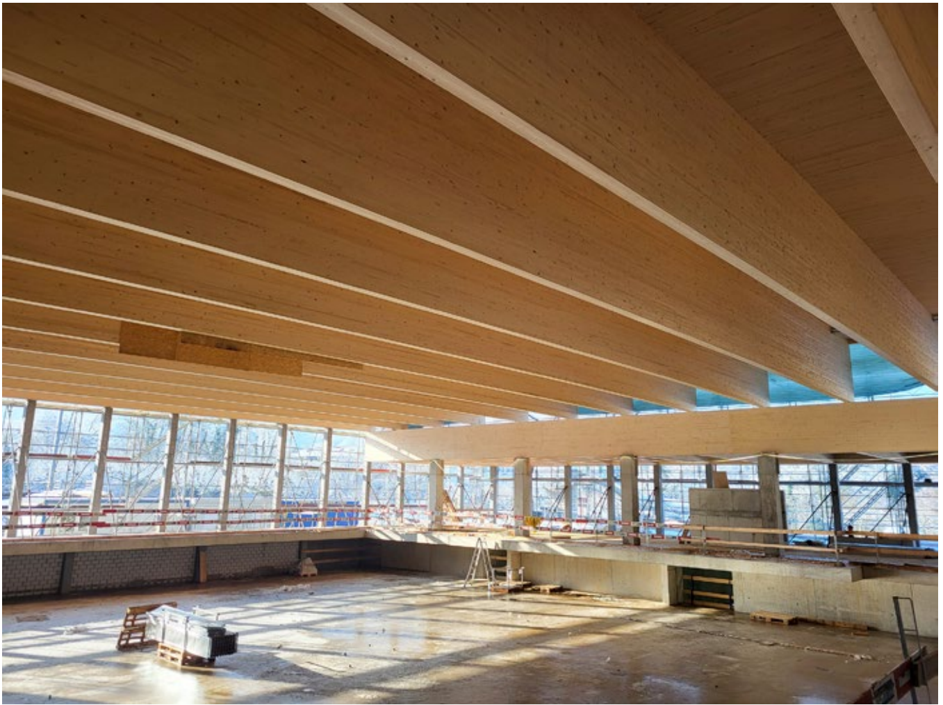
Dezember 2022: Erste Bauabschnitte sichtbar. Blick in die Tragstruktur der Schwimmhalle.
