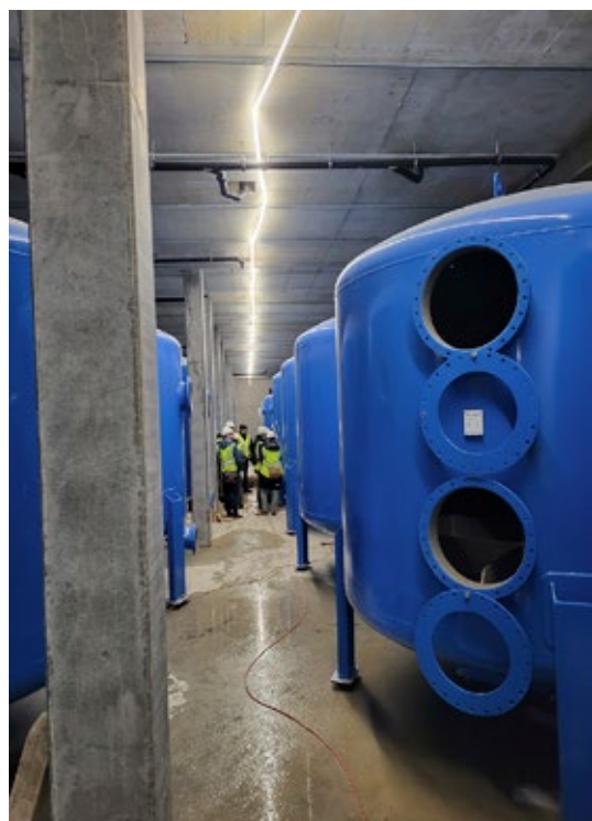
Vorinstallierte Wasserfiltration.
