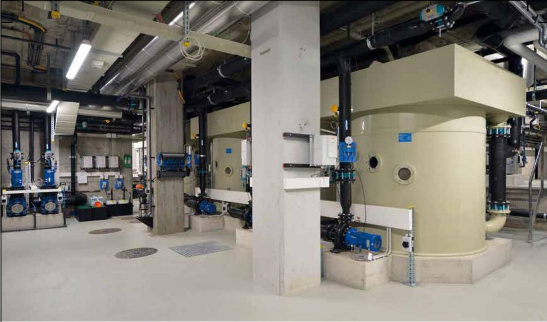
Freizeitbad Opfikon, Unterdruckfilter, Q 380 m<sup>3</sup>/h
