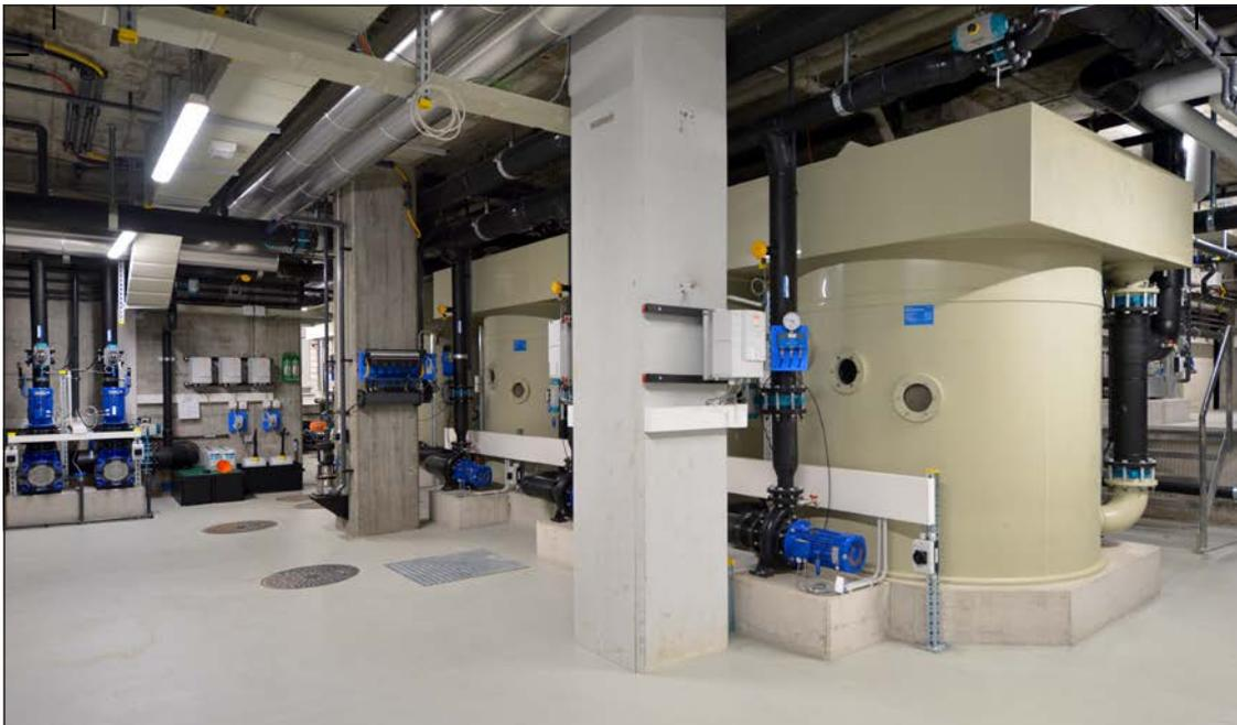
Freizeitbad Opfikon, Unterdruckfilter, Q 380 m<sup>3</sup>/h
