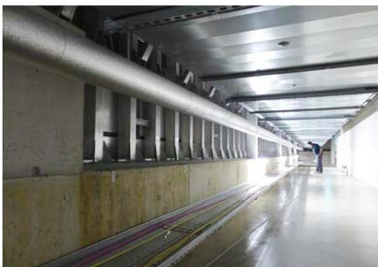
Das 50-Meter-Edelstahlbecken mit Fundationen im Technikgeschoss.
