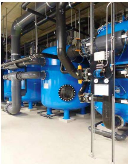
Drei der neun riesigen Filterkessel für die Wasserreinigung der gesamten Schwimmhalle.
