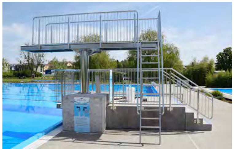
Die erneuerte 1-Meter- und 3-Meter-Sprunganlage.
