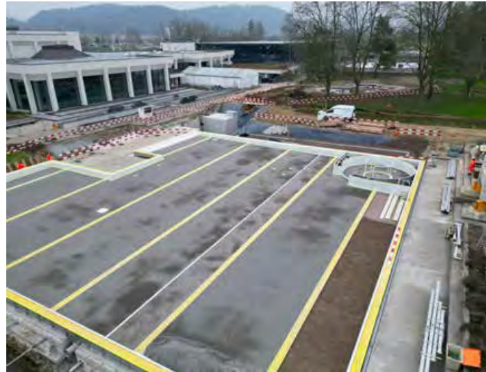
Totalsanierung des Kinderplanschbeckens 2022/23 im Hintergrund, der gesamten Gartenbadtechnik und der Leitungsführungen samt Einbau des Chromstahlbeckens im Nichtschwimmerbereich.
