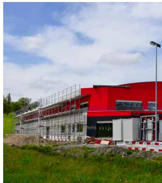
Die Baumassnahmen sind im April 2024 in vollem Gange.
