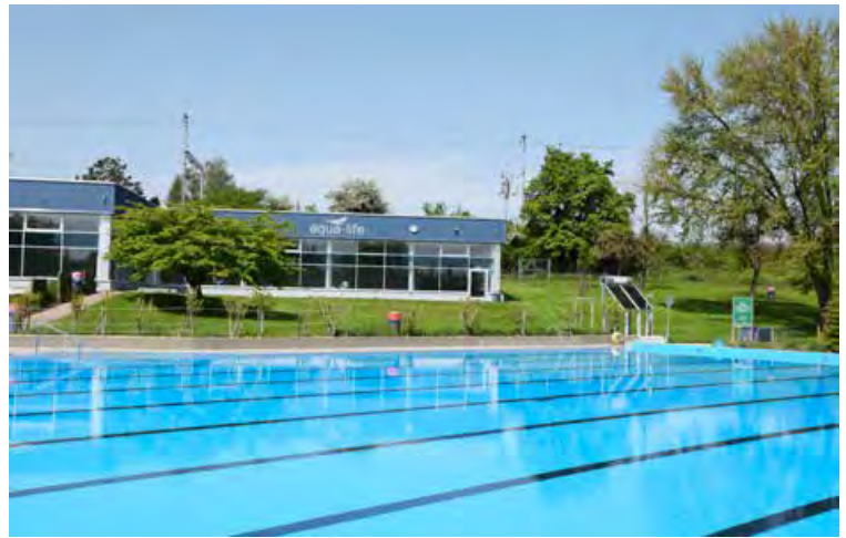
Blick vom 50-Meter-Schwimmbecken auf das Hallenbad.
