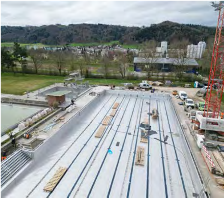
Situation Anfang April 2024: Der Ausbau des 50-Meter-Beckens sowie die Sanierung der Sprunganlage sind auf der Zielgeraden.
