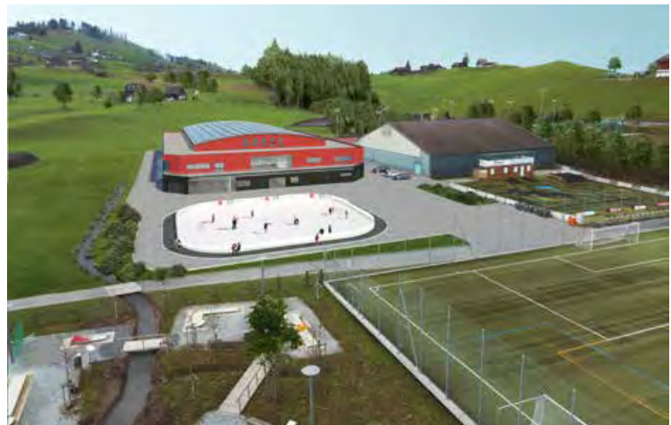
So soll die Anlage im Herbst in Betrieb gehen.
