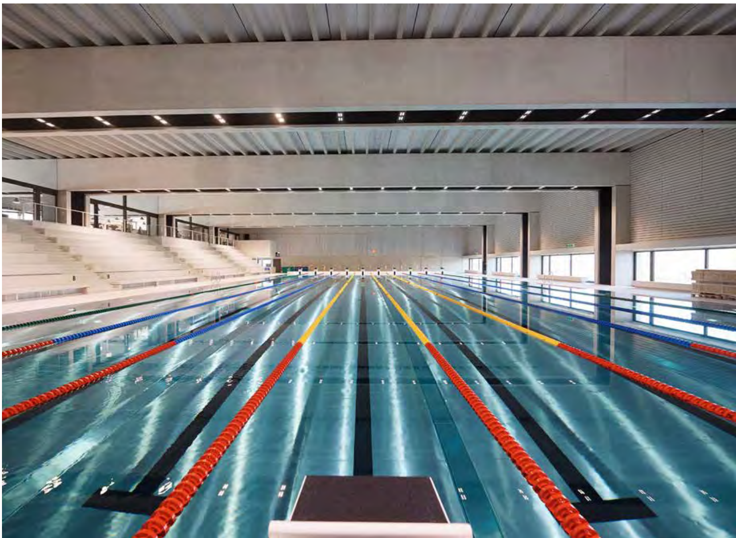
Die Einsatzmöglichkeiten von Chromstahlbecken in öffentlichen Schwimmbädern sind äusserst vielfältig. Auf dem Bild ist der 50-Meter-Olympic-Pool in der Campus Sursee Sportarena zu sehen.
