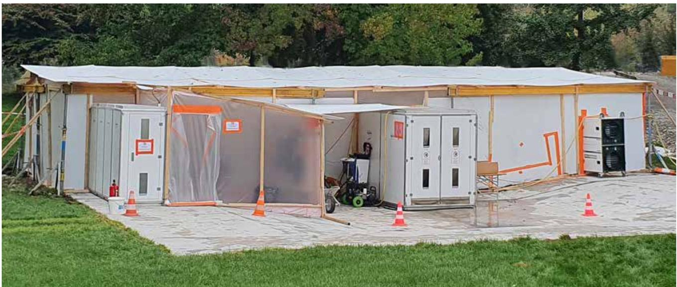
Auch im Aussenbereich sind für eine Asbestsanierung entsprechende Einhausungen notwendig.
