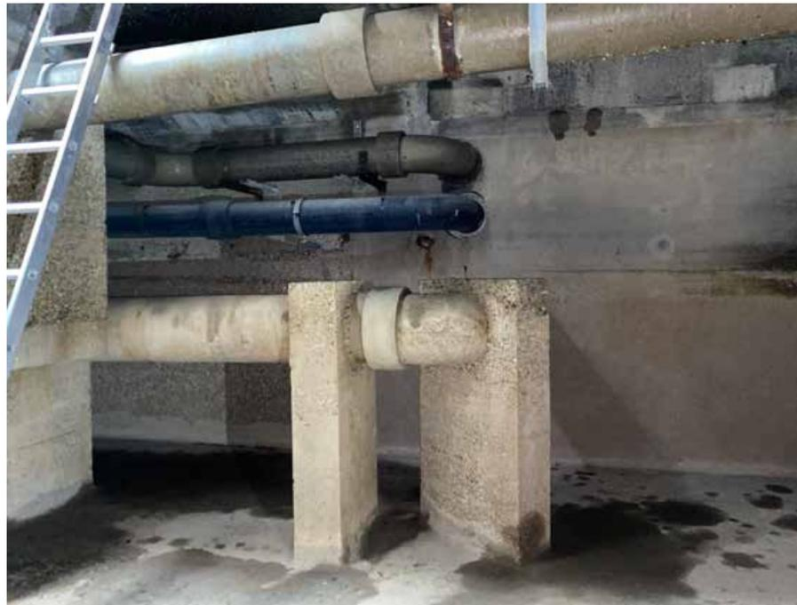
Asbesthaltige Faserzementleitungen in einem Ausgleichsbecken.
