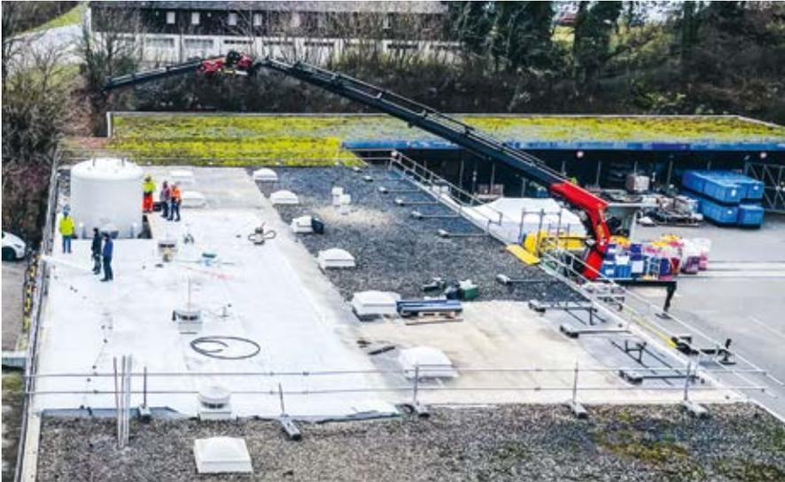
Der Einbau der neuen Tanks erfolgte bei laufendem Betrieb.
