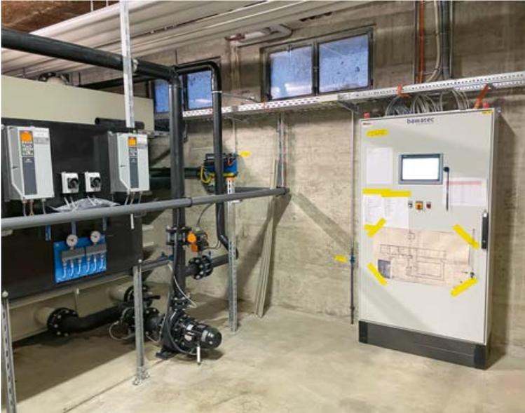
Markante Neuerung mit stärkeren Pumpen und zwei grossen Unterdrucksandfiltern sowie die Steuerungskonsole.
