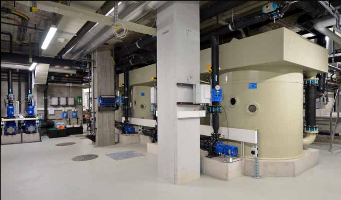
Freizeitbad Opfikon, Unterdruckfilter, Q 380 m<sup>3</sup>/h
